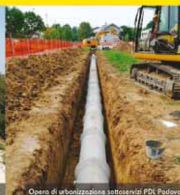
Opera di urbanizzazione sottoservizi PD Padova
