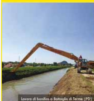
Lavoro di bonifica a Battaglia di Terme (PD)
