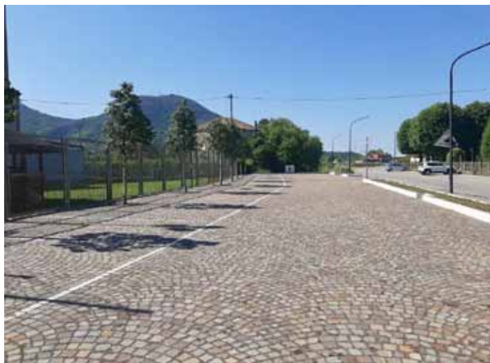
Particolari della pavimentazione in porfido e dei nuovi alberi
