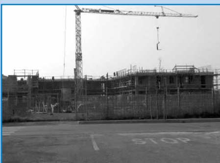
La casa per anziani in costruzione
