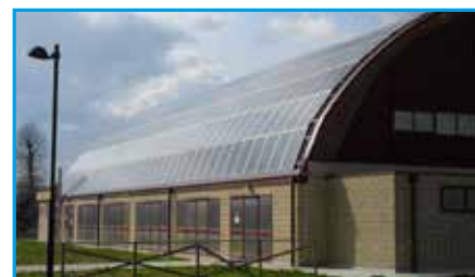
Palestra "Taccon" con fotovoltaico
