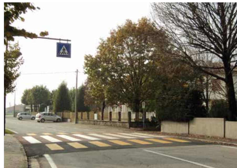
Sicurezza stradale: attraversamento rialzato via Albettoniera
