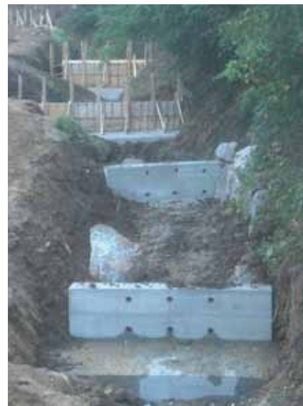
Scolo Figaro, sistemazione idrogeologica
