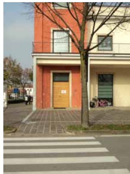
Abbattimento barriere architettoniche: scivolo disabili
